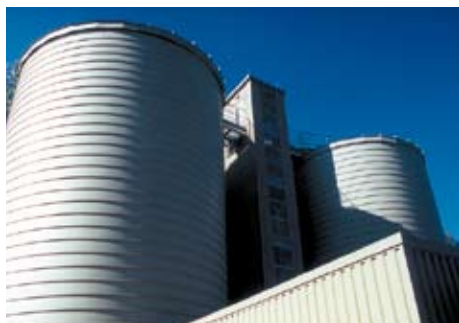
Bild 1: Zweistufige Hochleistungsanlage zur Vergärung von Klärschlamm in Leonberg. Figure 1: Two-stage high-performance plant for sewage sludge digestion, at Leonberg (Germany).
