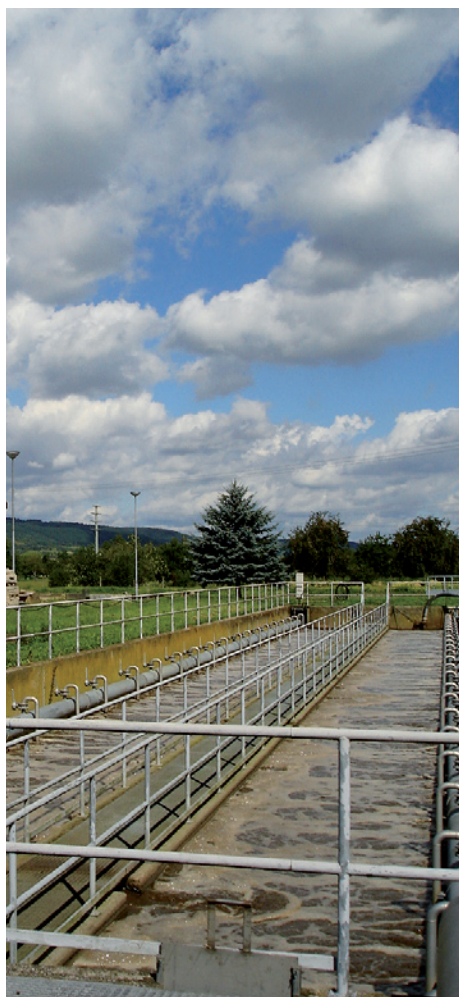
Bild 2: Belebungsbecken einer Kläranlage. Das Fraunhofer IGB optimiert und erweitert bestehende Abwasserreinigungsanlagen nach systematischer Analyse und spezifischen Messungen. Figure 2: Aeration tank of a treatment plant. Fraunhofer IGB uses systematic analysis and specific measurements to optimize and expand existing wastewater treatment plants.
