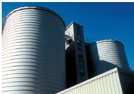
Bild 1: Zweistufige Hochleistungsanlage zur Vergärung von Klärschlamm in Leonberg. Figure 1: Two-stage high-performance plant for sewage sludge digestion, at Leonberg (Germany).
