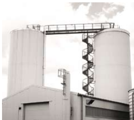
Bild 1: Hochlastfaulung mit Mikrofiltration, Stand der Technik für Kläranlagen > 50 000 EW (Einwohnerwerte).
