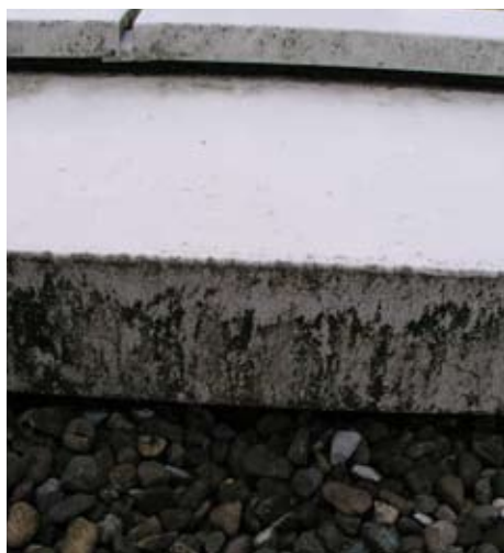
Bild 1: Bewuchs einer Hausfassade mit einem Biofilm aus Pilzen und Algen. Figure 1: Growth of a biofilm of fungi and algae on the facade of a house.
