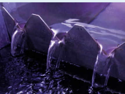
Entkeimung von Wasser mit UV-Licht.
